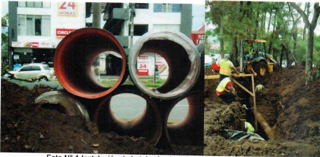
Foto N° 1 Instalación de la tubería pluvial municipal en la isleta, en el 2019.
